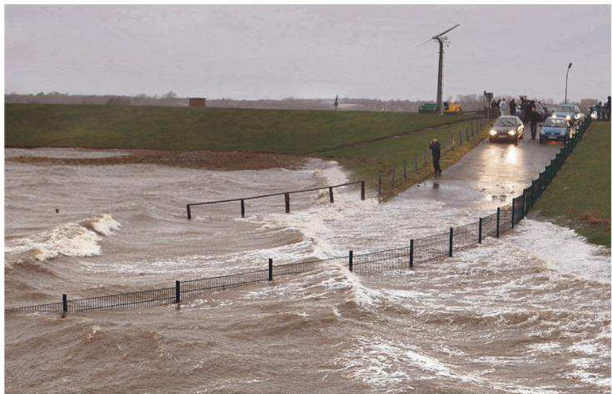
Schaulustige gestern an der Husumer Schleuse – die Anlegestelle war komplett überflutet.
